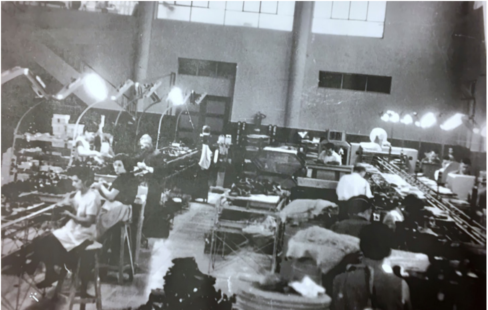
Fábrica de Siober en la calle Diego Fuentes Serrano.
