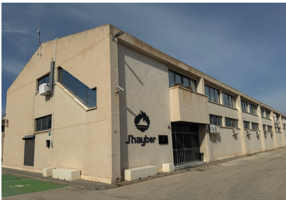
Oficinas de la empresa J'hayber en el polígono industrial Vizcarra.
